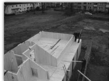
Beginn des Ausbaus 1. EG
