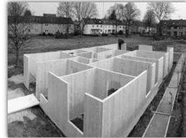
Alle Wände im EG stehen
